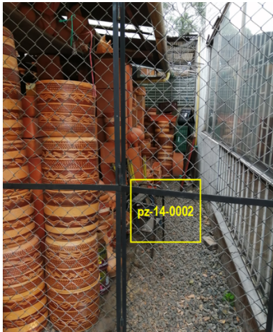
Foto No. 3. Vista general del pozo.
